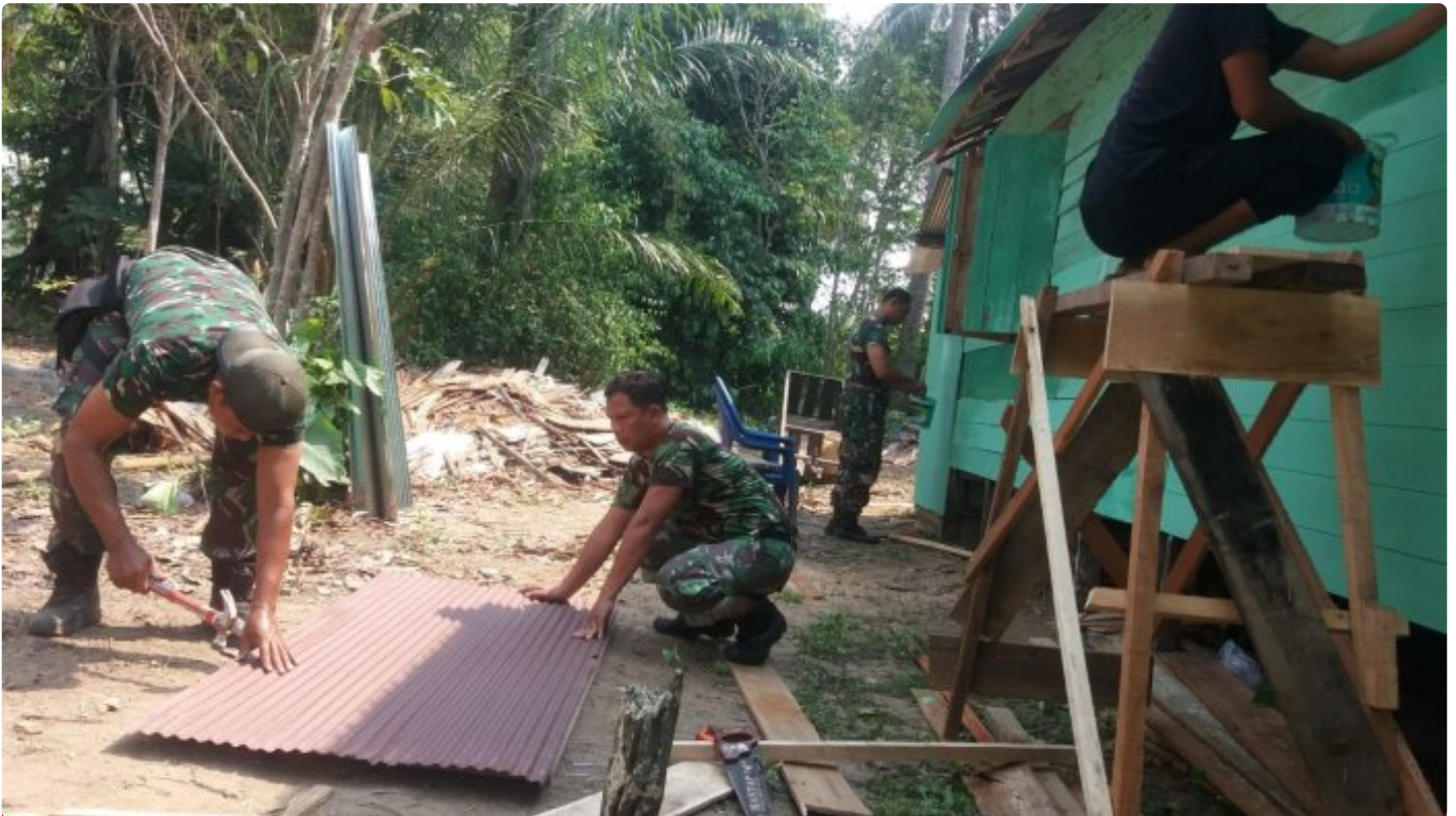
Gerak Cepat, Kodim 1002/HST Rehab Rumah M. Yusuf Capai 80 Persen
